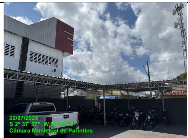
Foto 12 – Estrutura metálica com telhamento
