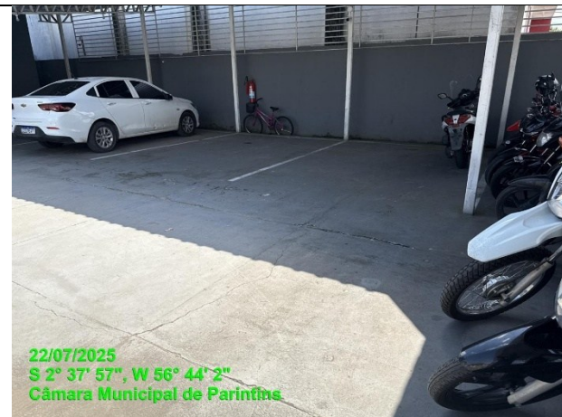
Foto 9 – Piso em concreto
