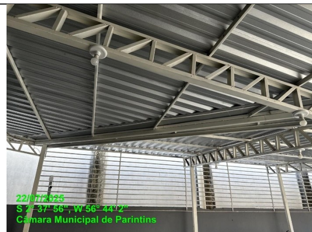
Foto 11 – Estrutura metálica com telhamento
