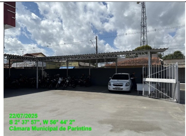
Foto 10 – Piso em concreto
