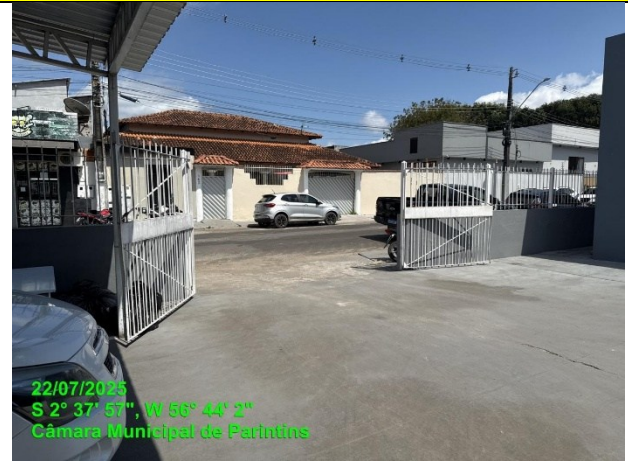
Foto 8 – Piso em concreto
