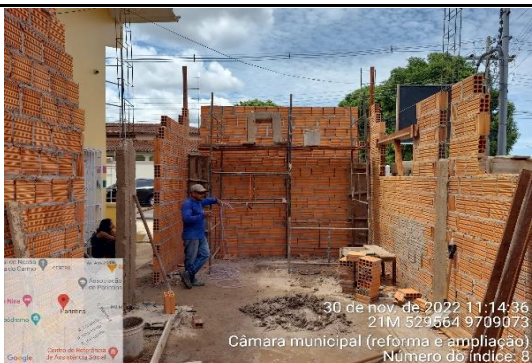
FOTO 5 - assentamento da alvenaria em andamento
