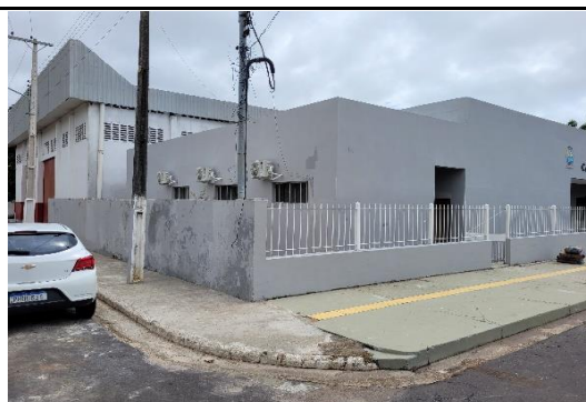
FOTO 6 - vista panorâmica da ampliação (nova sala) em destaque as condensadoras dos aparelhos de ar condicionado
