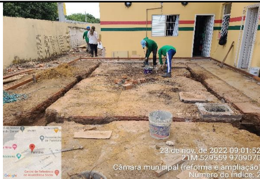
FOTO 2 - vista panorâmica onde serão construídas três salas (licitação, RH e financeiro)
