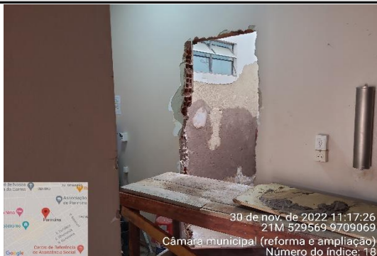
FOTO 13 - vão aberto para porta de novo banheiro
