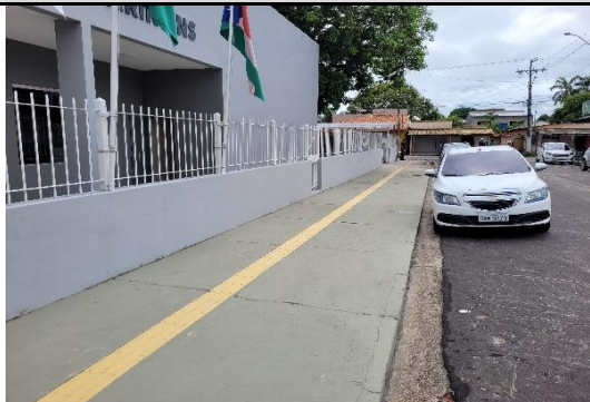
FOTO 7 - calçada da câmara com nova pintura no piso inclusive piso tátil em amarelo
