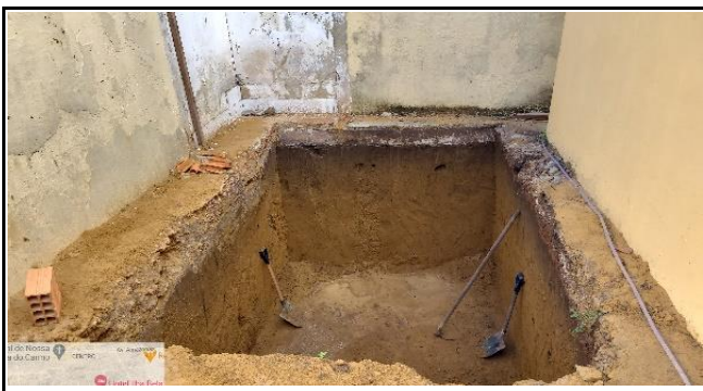
FOTO 23 - novo local da fossa séptica já escavado
