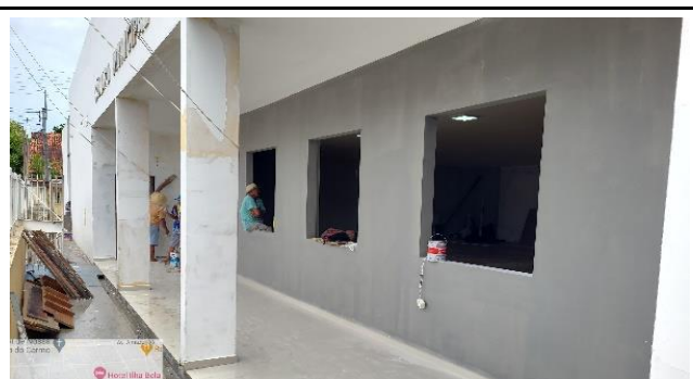
FOTO 11 - fachada câmara - vãos prontos para receber as novas esquadrias
