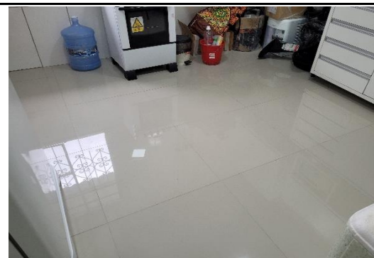
FOTO 12 - novo piso porcelanato na cozinha
