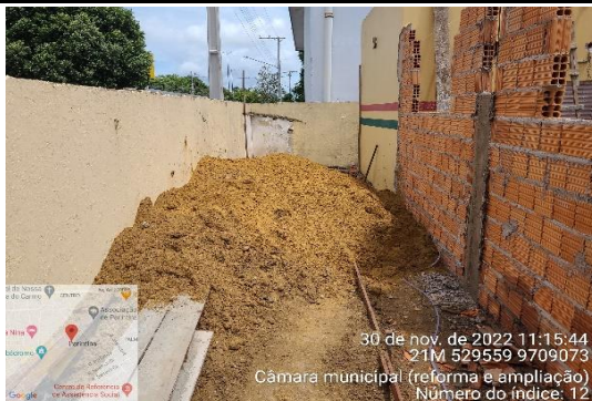
FOTO 7 - área onde será locada a nova fossa séptica
