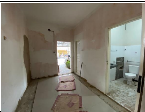
FOTO 30 - assentamento do novo piso porcelanato em andamento (sala espera/recepção)
