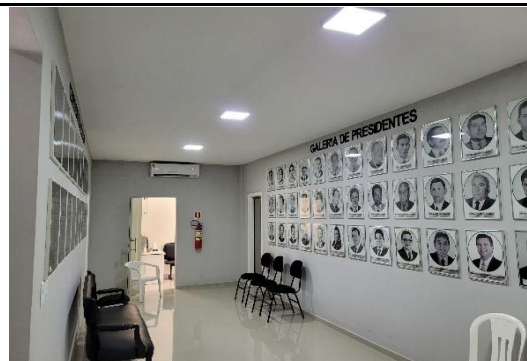
FOTO 10 - execução de forro de gesso (salão nobre)
