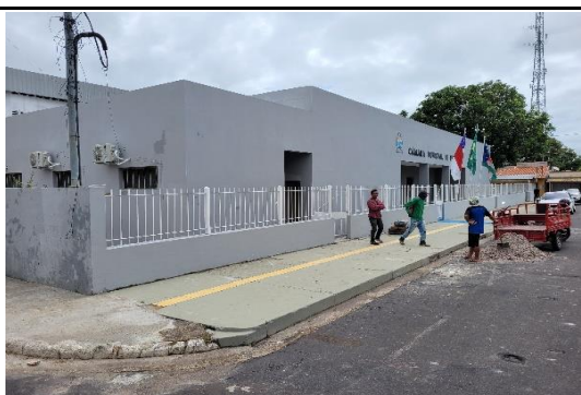
FOTO 5 - fachada e novas salas (externo)
