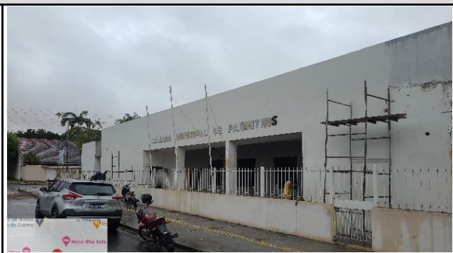
FOTO 1 - fachada câmara em fase final de pintura
