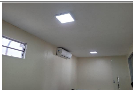
FOTO 17 - forro de gesso executado em nova sala dos acessórios
