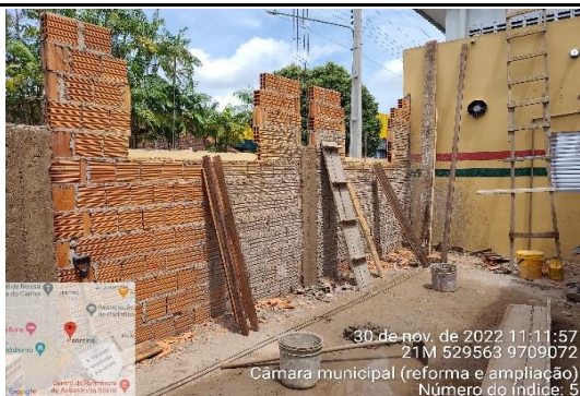
FOTO 3 - vista interna onde serão acrescentadas três salas
