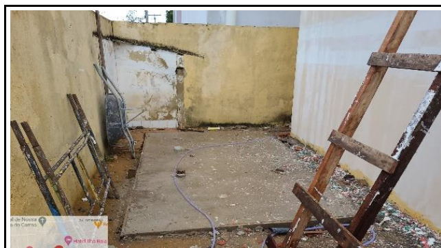
FOTO 4 - nova fossa séptica
