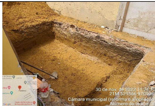
FOTO 18 - escavação de solo para nova fossa séptica em andamento
