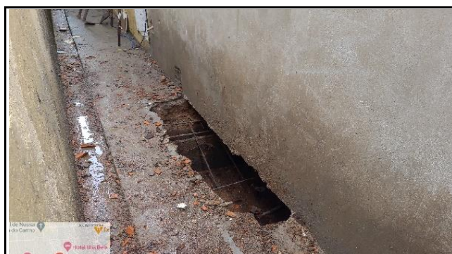
FOTO 6 - reparo em nova sala
