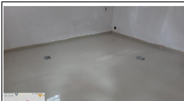
FOTO 10 - nova sala (ampliação) com novo piso porcelanato instalado
