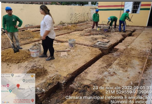
FOTO 1 - escavação de vala para vigas baldrame
