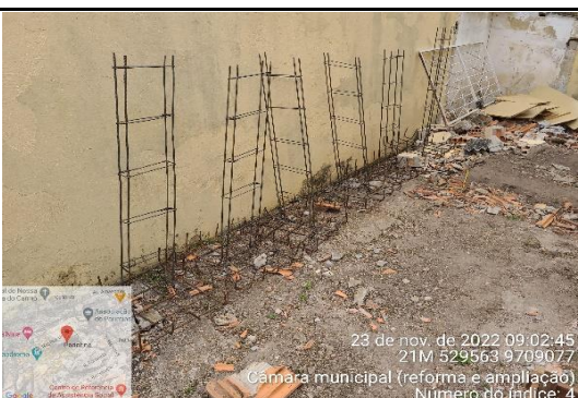
FOTO 4 - armadura (arranque dos pilares)
