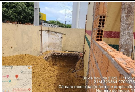
FOTO 8 - escavação para nova fossa séptica
