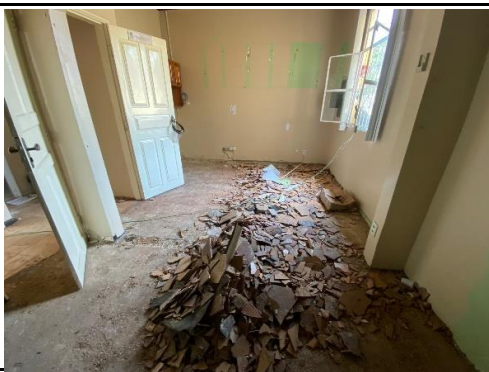
FOTO 27 - retirada do piso antigo (interior da câmara)
