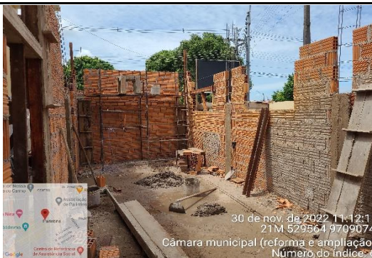
FOTO 4 - vista panorâmica interna (assentamento da alvenaria)
