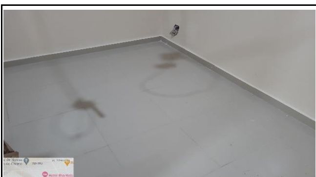
FOTO 5 - interior da câmara cômodos reformados. Instalação de piso porcelanato concluído
