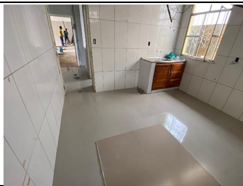
FOTO 33 - assentamento do novo piso porcelanato concluído (salas internas)
