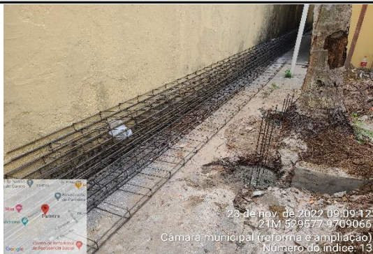
FOTO 13 - estoque de armadura para utilização em vigas
