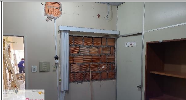
FOTO 14 - fechamento de vão sala de arquivo
