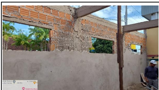
FOTO 4 - vista interna de novo ambiente de três salas. Reboco em andamento
