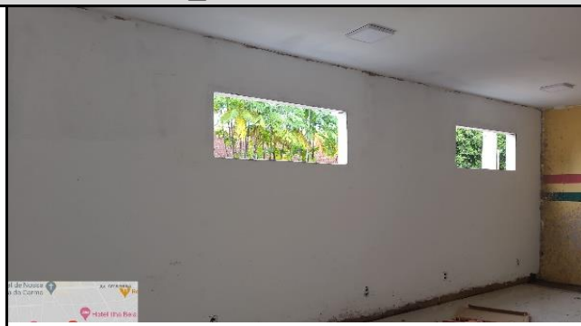
FOTO 2 - nova sala (ampliação)
