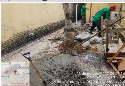
FOTO 8 - preparação para concretagem das brocas (arranque de pilares)
