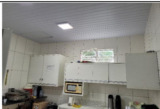
FOTO 11 - executado novo forro de PVC na cozinha
