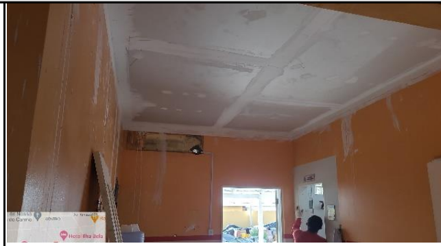
FOTO 20 - novo forro executado recepção câmara
