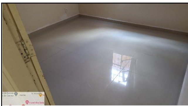
FOTO 6 - sala reformada com novo piso e tratamento das paredes
