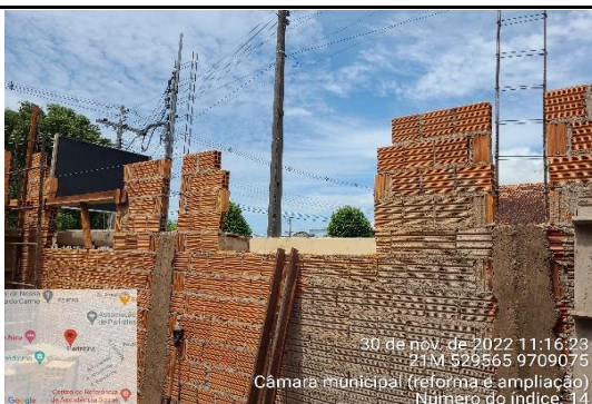
FOTO 9 - detalhe (abertura vãos para esquadrias)
