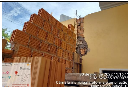
FOTO 10 - detalhe de armadura de pilar
