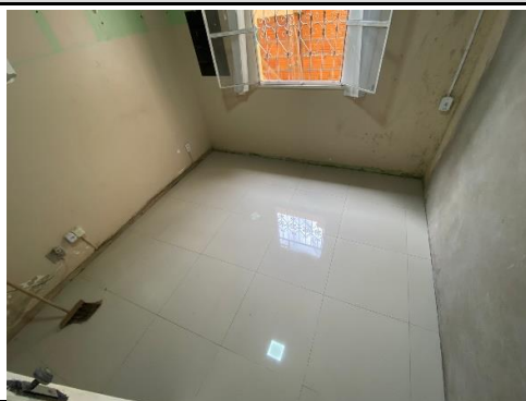
FOTO 31 - assentamento do novo piso porcelanato concluído (salas internas)
