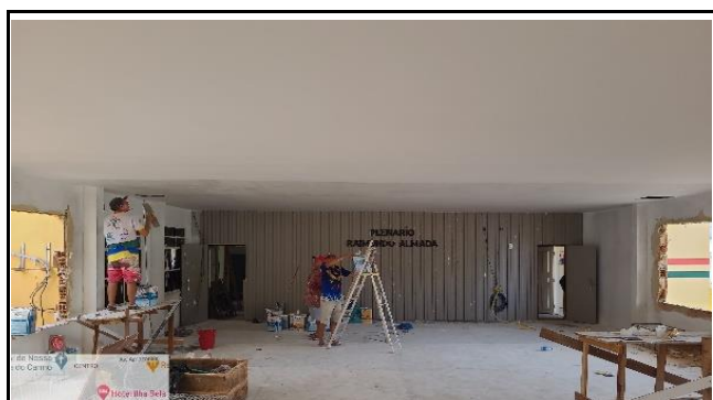
FOTO 18 - vista panorâmica do plenário com emassamento do novo forro executado
