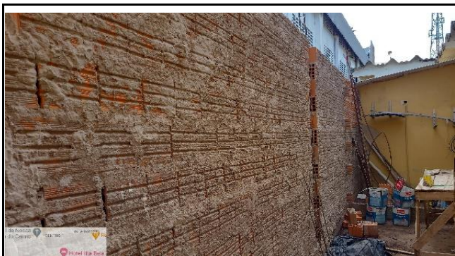
FOTO 9 - nova alvenaria de fechamento (lateral câmara)
