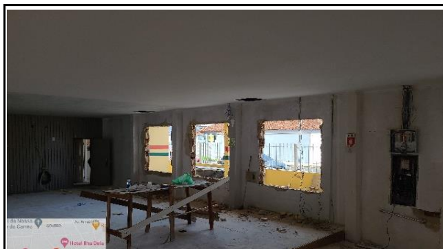
FOTO 12 - vão fechado (vista interna)
