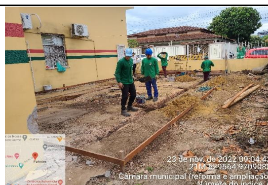
FOTO 6 - gabarito da obra
