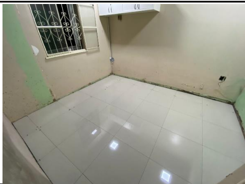
FOTO 30 - assentamento do novo piso porcelanato concluído (salas internas)
