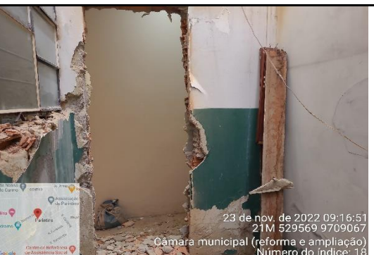
FOTO 18 - abertura de vão para novo banheiro executado
