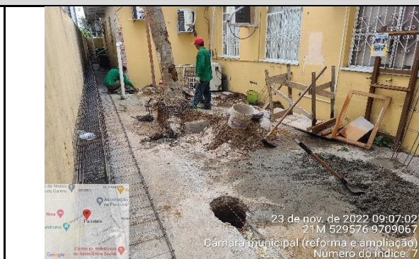
FOTO 7 - área onde será ampliado (sala de transmissão e acessoria)
