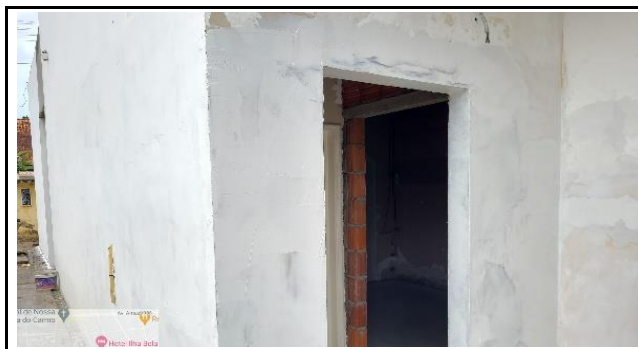
FOTO 12 - emassamento e pintura
