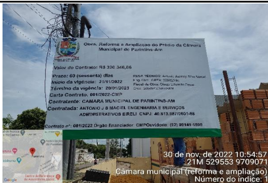
FOTO 1 - placa da obra
