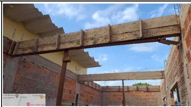
FOTO 2 - fôrma de viga superior concretada
