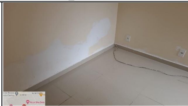
FOTO 8 - tratamento das paredes nas salas internas da câmara
