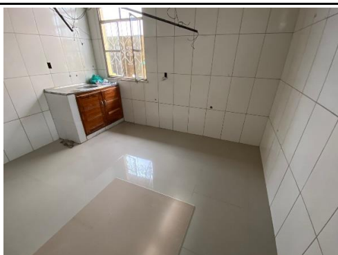
FOTO 34 - assentamento do novo piso porcelanato concluído (cozinha)
