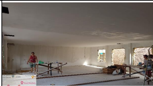
FOTO 14 - execução de novo forro de gesso do plenário
