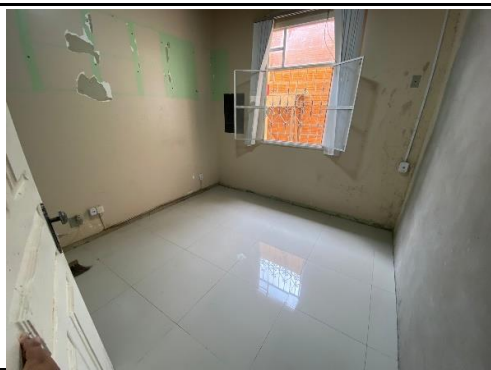
FOTO 32 - assentamento do novo piso porcelanato concluído (salas internas)
