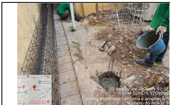
FOTO 9 - detalhe de broca concretada com armadura
