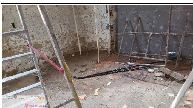
FOTO 17 - salas com antigo piso retirados
