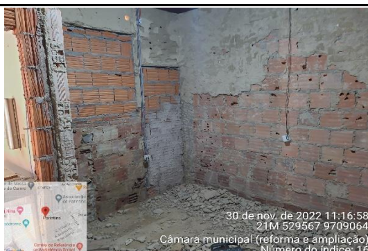
FOTO 12 - vão fechado (vista interna)
