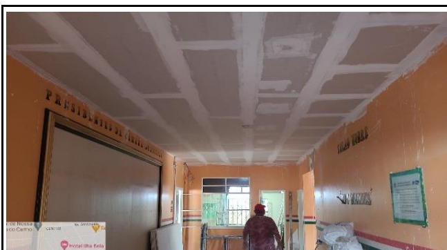
FOTO 15 - execução de novo forro de gesso do saguão
