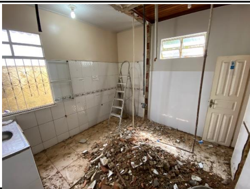
FOTO 25 - retirada manual de piso antigo
