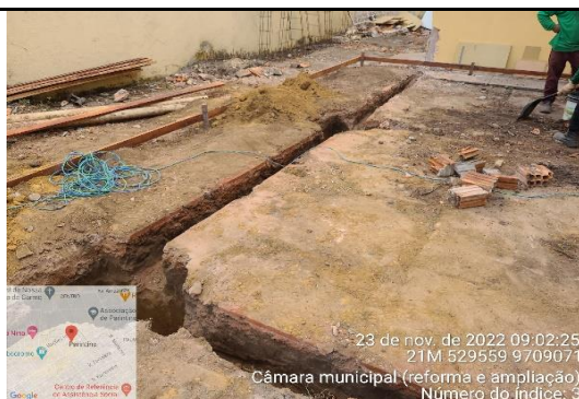
FOTO 3 - gabarito e escavação das valas
