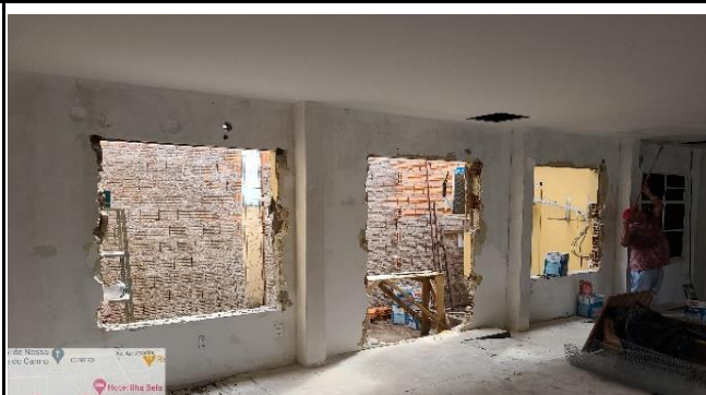
FOTO 13 - demolição de esquadrias antiga
