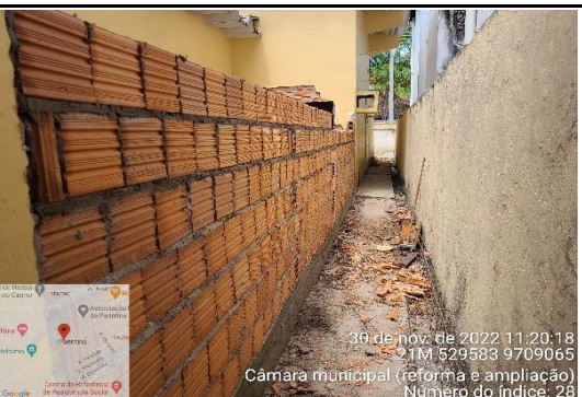
FOTO 17 - vista externa (nova alvenaria de fechamento) ampliação lateral
