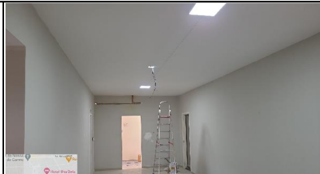
FOTO 8 - vista panorâmica salão nobre - pintura, forro de gesso e luminárias concluídos
