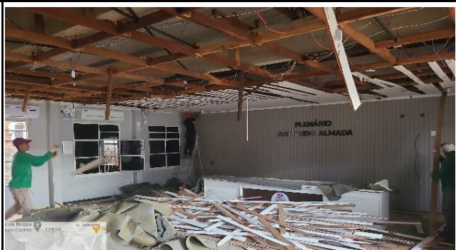
FOTO 19 - início da demolição do forro do plenário
