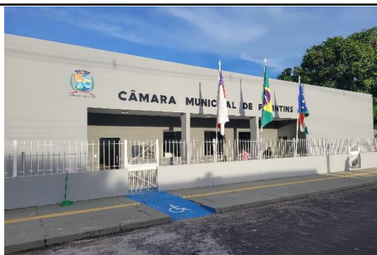
FOTO 3 - nova fachada da Câmara
