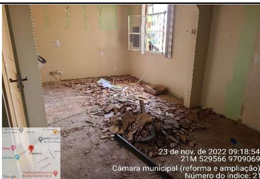
FOTO 21 - sala com remoção do piso cerâmico antigo
