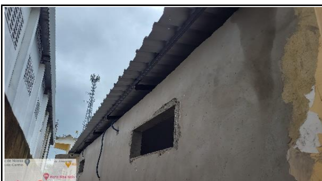
FOTO 5 - nova sala (ampliação) lateral da câmara
