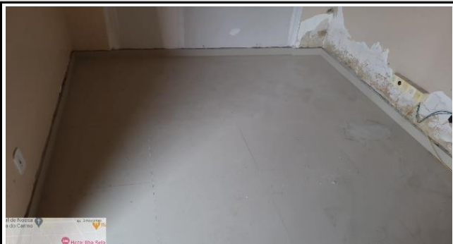
FOTO 13 - novo piso porcelanato instalado
