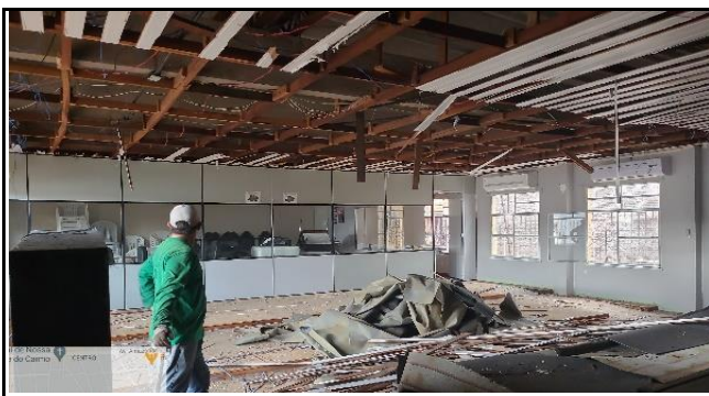
FOTO 21 - vista panorâmica do plenário (retirada de forro e carpete)
