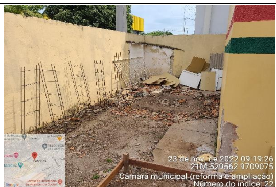
FOTO 22 - área onde será a nova fossa séptica
