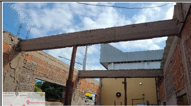
FOTO 1 - vigas superiores concretadas
