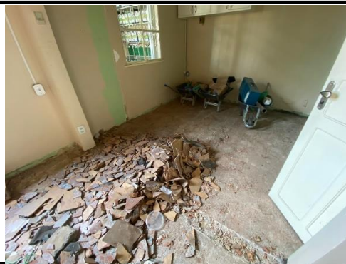
FOTO 26 - piso antigo sendo retirado
