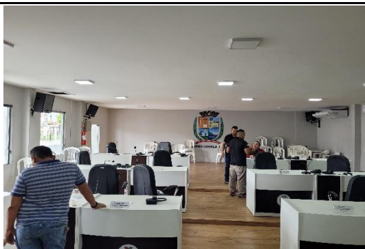
FOTO 15 - vista panorâmica do plenário com destaque para o novo forro de gesso
