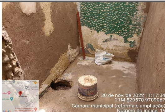
FOTO 14 - escavação para passagem de tubulação sanitária)
