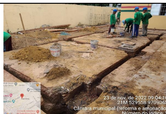
FOTO 5 - vista panorâmica da escavação das valas
