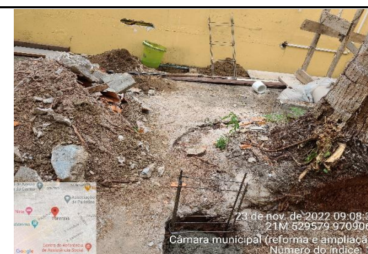
FOTO 12 - preparação escavação de vala para viga baldrame
